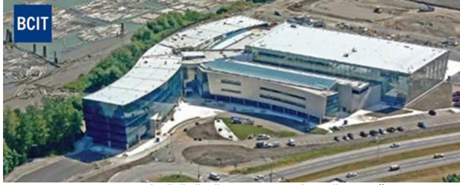
BCIT ATC Genel Görünümü – KuzeyBatıdan GüneyDoğuya
