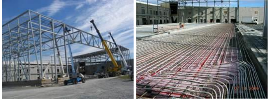
Eğitim Hangarı İnşaatından Görüntüler
