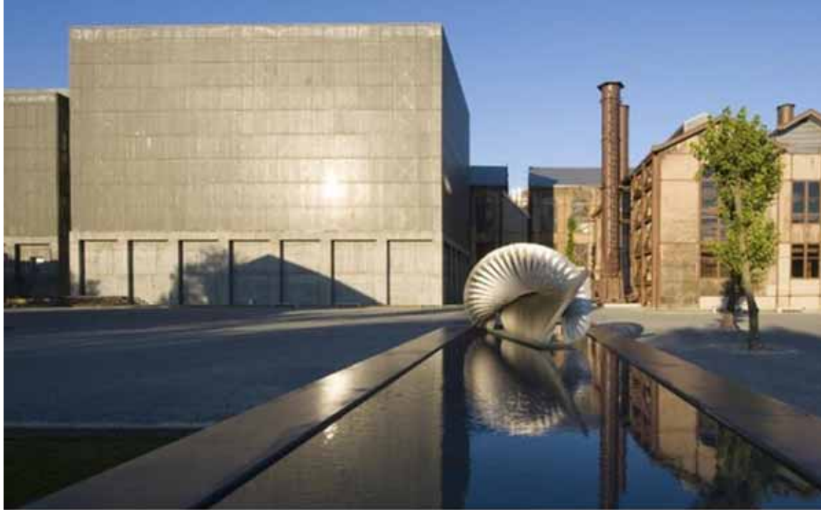
Silahtarağa Elektrik Santralı #3 & #4 Kazan Daireleri > Çağdaş Sanatlar Müzesi © www.bilgi.edu.tr
