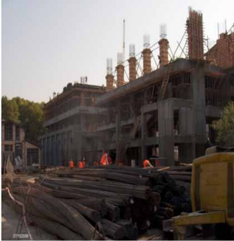
Silahtarağa Elektrik Santralı – Dönüşüm Projesi 2004 © www.bilgi.edu.tr
