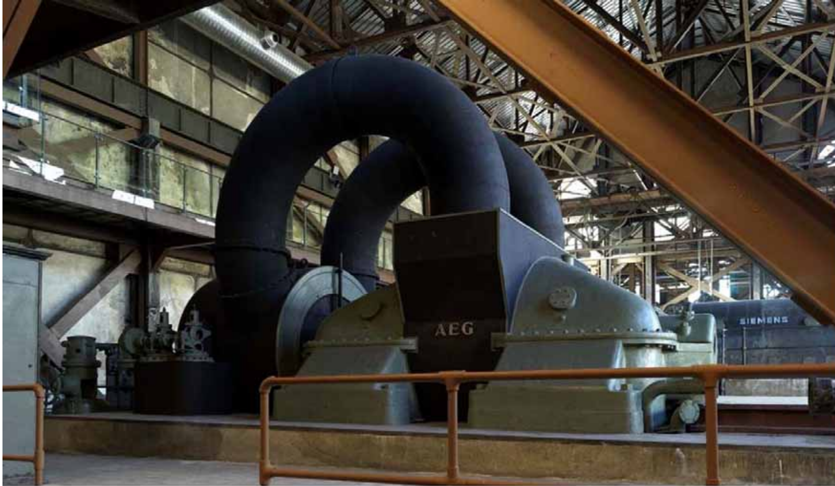
Silahtarağa Elektrik Santralı #1 Makina Dairesi > Enerji Müzesi © www.mekaniktasarim.com
