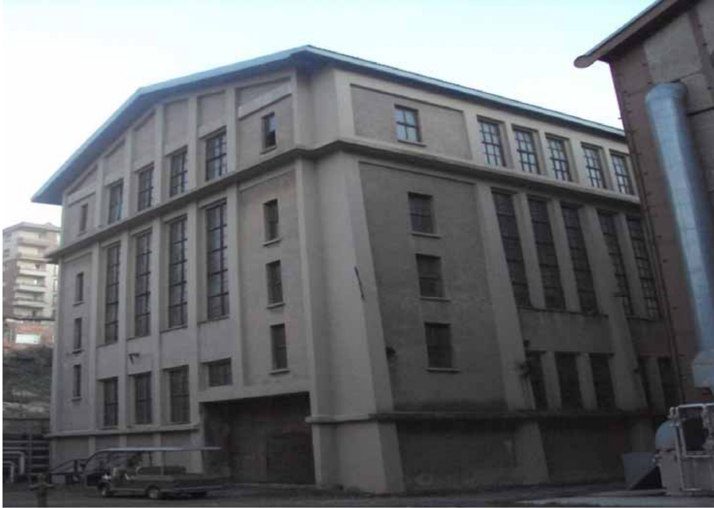
Silahtarğa Elektrik Santrali #3 Makine Dairesi - Seyfi Arkan (1944) © www.bilgi.edu.tr
