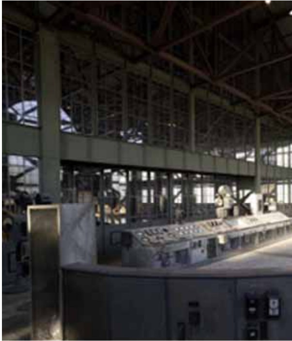
Silahtarğa Elektrik Santrali #1 & #2 Makina Dairesi > Enerji Müzesi © www.bilgi.edu.tr
