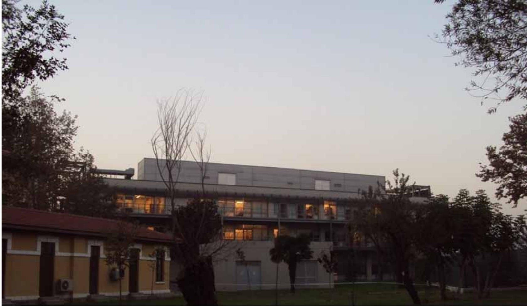
Silahtarağa Elektrik Santrali İBÜ E2 Derslikleri Binası © www.bilgi.edu.tr
