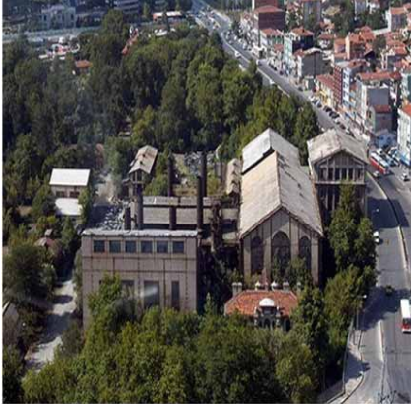
Silahtarağa Elektrik Santrali - 1983 © www.bilgi.edu.tr
