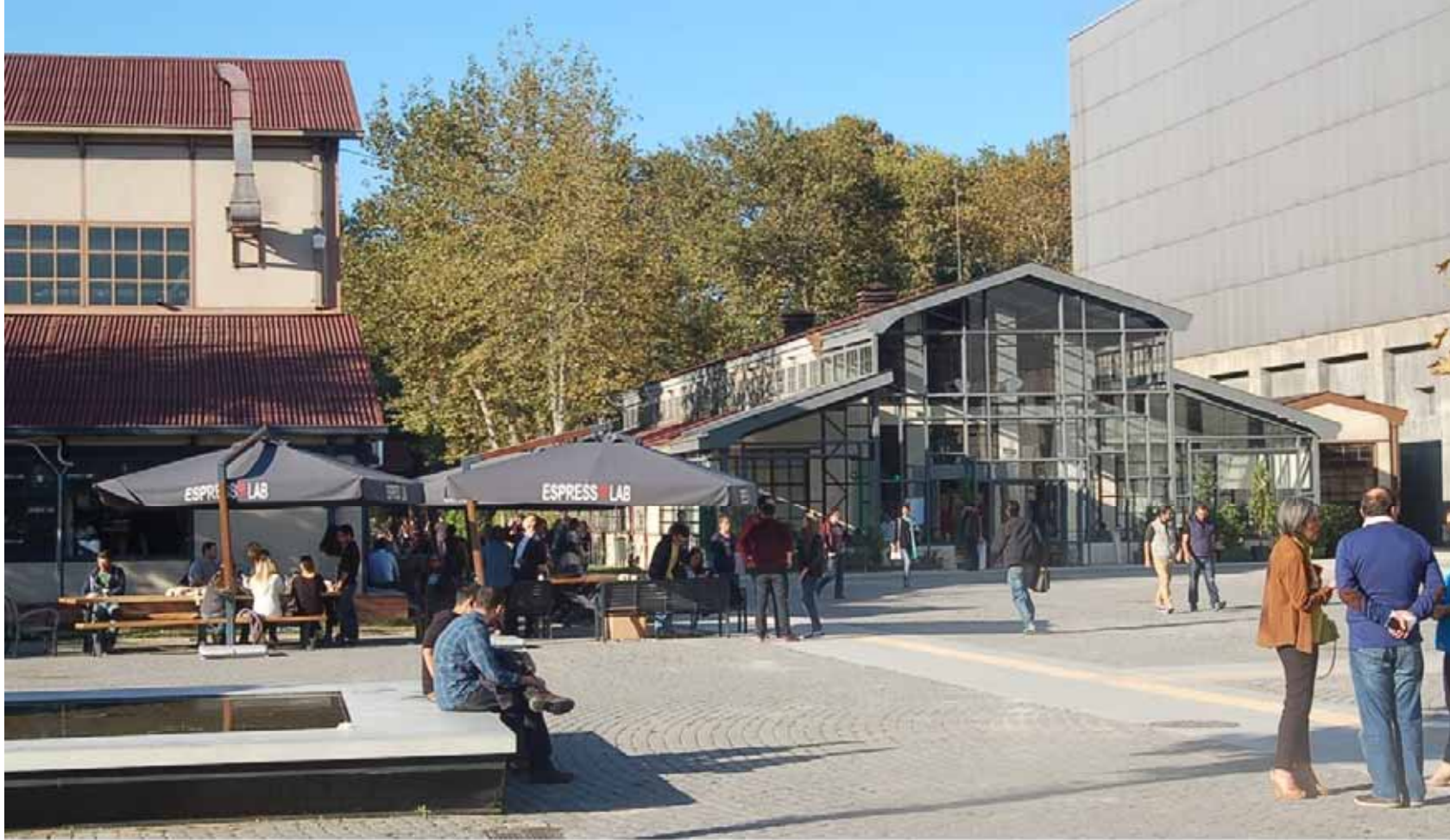
Silahtarğa Elektrik Santralı Tamir Atölyesi > İBÜ "Papaz Restaurant" © www.bilgi.edu.tr
