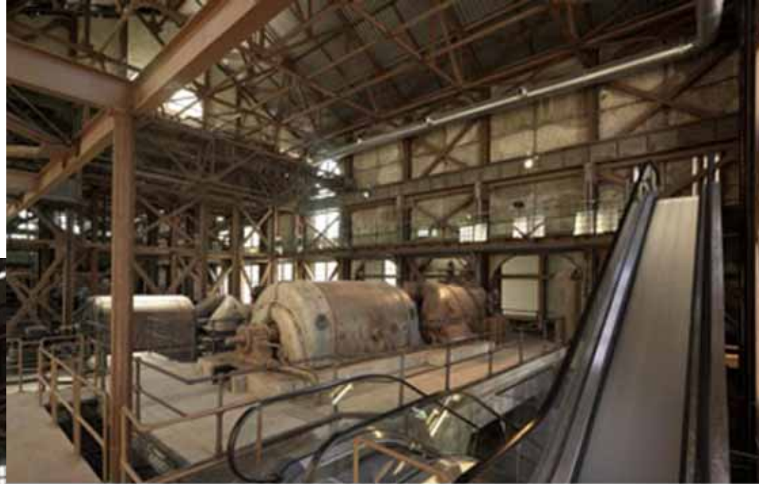
Silahtarğa Elektrik Santrali #1 & #2 Makina Dairesi > Enerji Müzesi © www.bilgi.edu.tr
