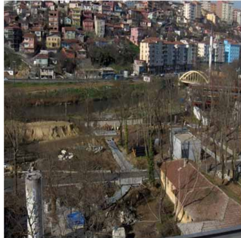
Silahtarağa Elektrik Santrali - 1983 © www.bilgi.edu.tr
