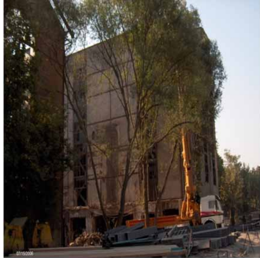
Silahtarağa Elektrik Santralı – Dönüşüm Projesi 2004 © www.bilgi.edu.tr
